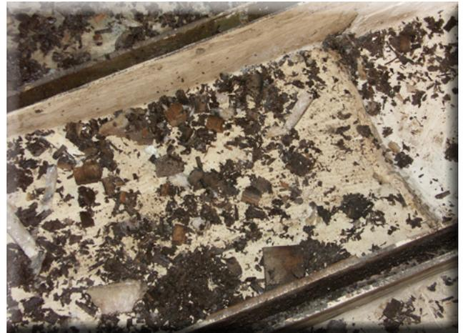
Vermodertes Holz kann leicht mit einem spitzen Gegenstand aus dem Laminat entfernt werden (Torfstechen)
