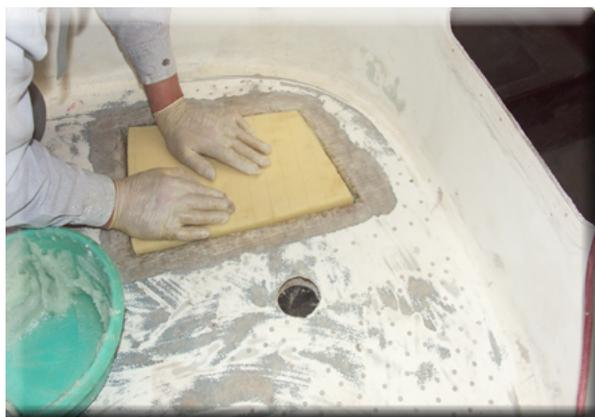
Sandwichstrukturen werden instand gesetzt. Hier: Der Ersatz einer kompletten Sandwichstruktur und Harzinjektion in Kombination
