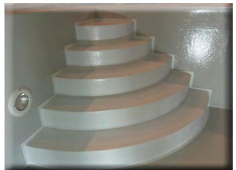
HP-PP-TEXTUR sorgt im Vergleich zum HP-PP für eine rutschfeste und strukturierte Oberfläche und ist daher besonders gut für Stufen im Becken geeignet. Der Decklack ist ebenfalls lieferbar in fast allen RAL-Farbtönen!
