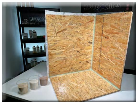
Nachdem die erste Schicht Epoxidharz angetrocknet, aber noch leicht klebrig ist, wird eine zweite Schicht aufgetragen.
