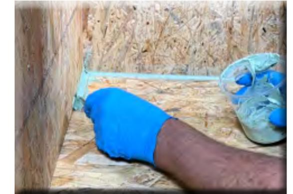
Auftragen der Epoxi-Spachtelmasse
