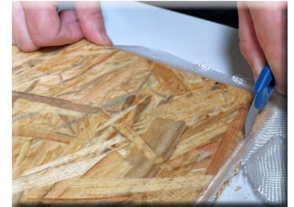
Überschüssiges Glasgewebe wird abgeschnitten
