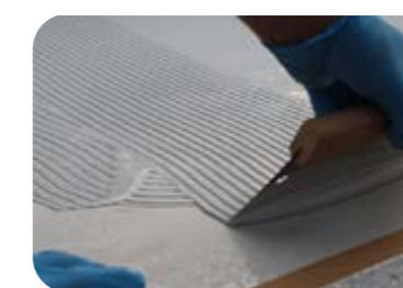
Beschichtung eines Futtertisches
